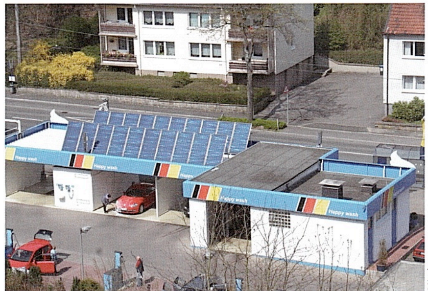
Umweltfreundlich und kostensparend: Solarkollektoren mit mehr als 50 Quadratmeter Fläche für die Warmwassererzeugung.
