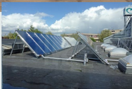
Voll integriert: 52 Solarthermiekollektoren mit 130 qm Fläche für den Cleanline-Waschpark.
