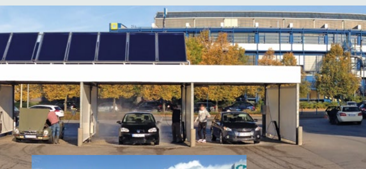
Voll integriert: 52 Solarthermiekollektoren mit 130 qm Fläche für den Cleanline-Waschpark.
